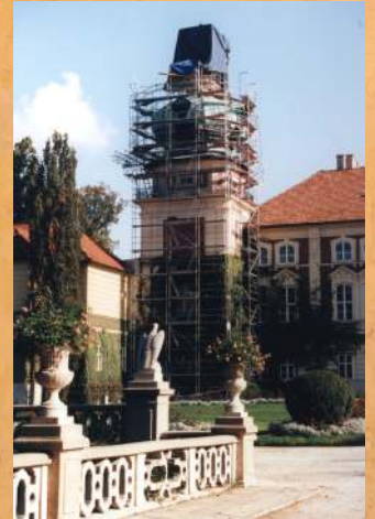
Remont hełmu na wieży. 2003 r.
