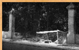
Instalacja nowej bramy od strony ul. Zamkowej. 1965 r.
