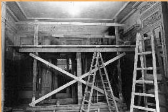
Remont Salonu Kolumnowego. 1969 r.
