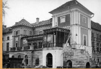
Odnowiona elewacja południowa. 1972 r.
