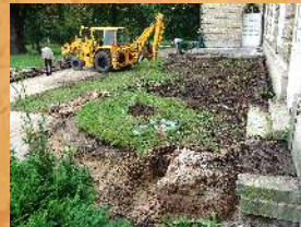
Remont tarasu północnego. 2005 r.
