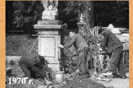
Prace przy mo cie zachodnim. 1970 r.
