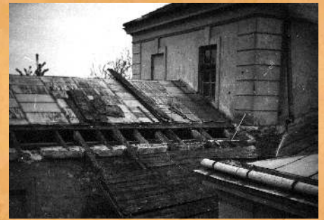
Remont dachu nad budynkiem Stajni w 1958 r.
