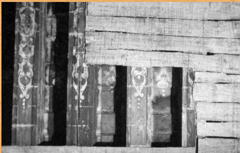
Odkrycie polichromowanego stropu z 1642 roku w czasie prac remontowych przeprowadzonych w 1958 r.
