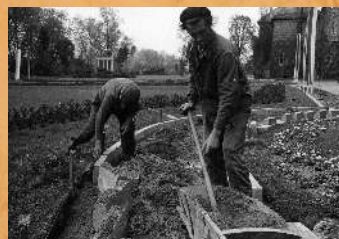
Zakładanie krawężników i utwardzanie alejek. 1967 r.
