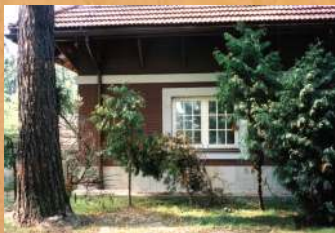
Zakończono remont budynku gospodarczego Storczykarni - ciepłowni gazowej. 2001 r.
