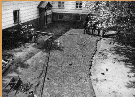
Reparacja nawierzchni dziedzińca ca. 1965 r.
