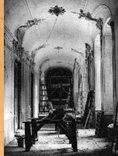
Korytarz Biały w trakcie konserwacji. 1969 r.
