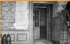
Prace remontowe w Zameczku Romantycznym. 1965 r.
