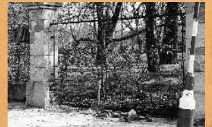
Naprawa ogrodzenia od strony ul. Zamkowej. 1994 r.
