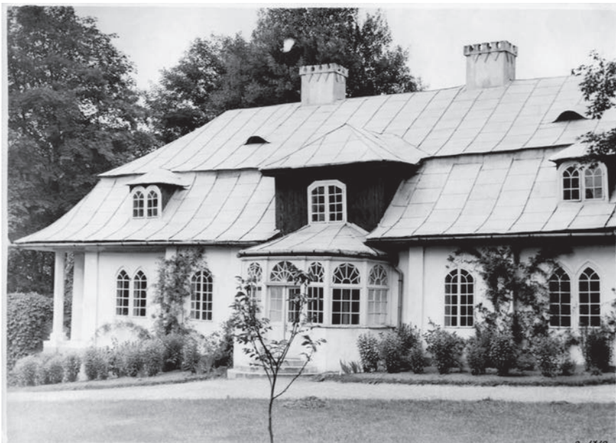
36. Pałacyk w Potoku. Fot. z 1932 r. Arch. MZŁ
