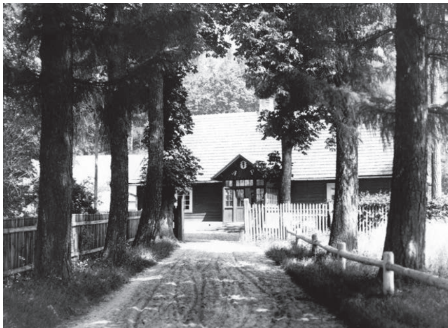
15. Leśnictwo w Brzózce, po przebudowie za II ordynata. Fot. z 1932 r. arch. MZŁ
